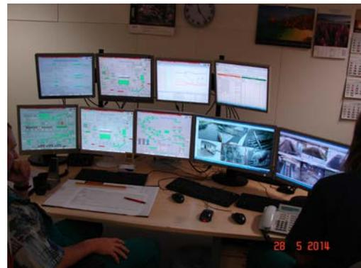
Bild 4: Leitstand der mechanisch-physikalischen Restabfallbehandlungsanlage in Chemnitz
